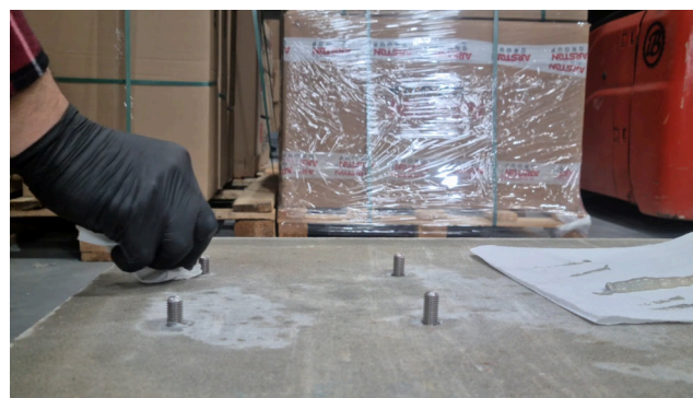
4. Tørk bort overfladig fyllmasse
