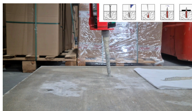
1. Skvis ut litt fyllmasse på et ark (ca 80-100mm)
