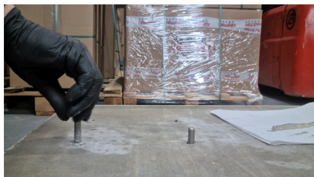
3. Sett gjengestenger (M10/200mm) nedi hylsene med fyllmasse
